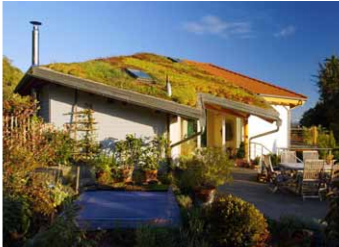
Abb. 2 Eine interessante Kombination aus Gründach und Ziegeldach weist dieses Haus in Sipplingen am Bodensee auf. Unter der Begrünung wurden Hartschaum-Elemente eingesetzt.
