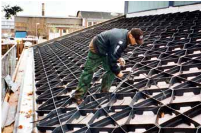
Abb. 3 Diese rasterförmig zu verlegenden Elemente aus Recycling-Kunststoff sind für den Einsatz bis ca. 35° Neigung konzipiert.
