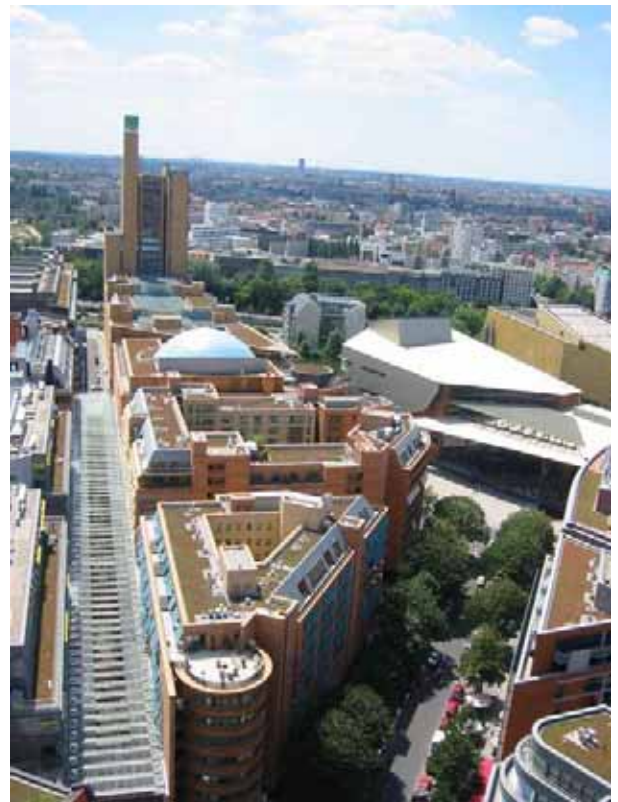
Foto 2 Dachbegrünung am Potsdamer Platz, DCI
