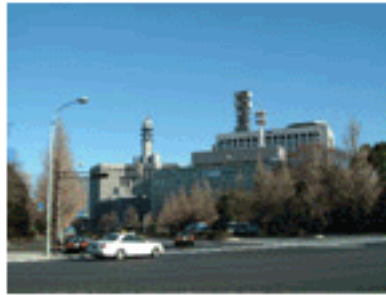
Kasumigaseki Regierungsbüro Straße
