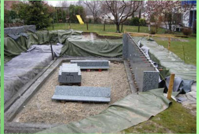
Und als Epoche machende Neuerung haben wir die Auskleidung des Badebereiches mit Granitplatten sowie ein ausgeklügeltes Reinigungssystem im Boden des Badebereiches eingeführt. Zudem empfehlen wir dem anspruchsvollen Kunden das Zweikammersystem, weil die Algenbildung zumeist im bepflanzten Bereich ihren Ursprung hat.
