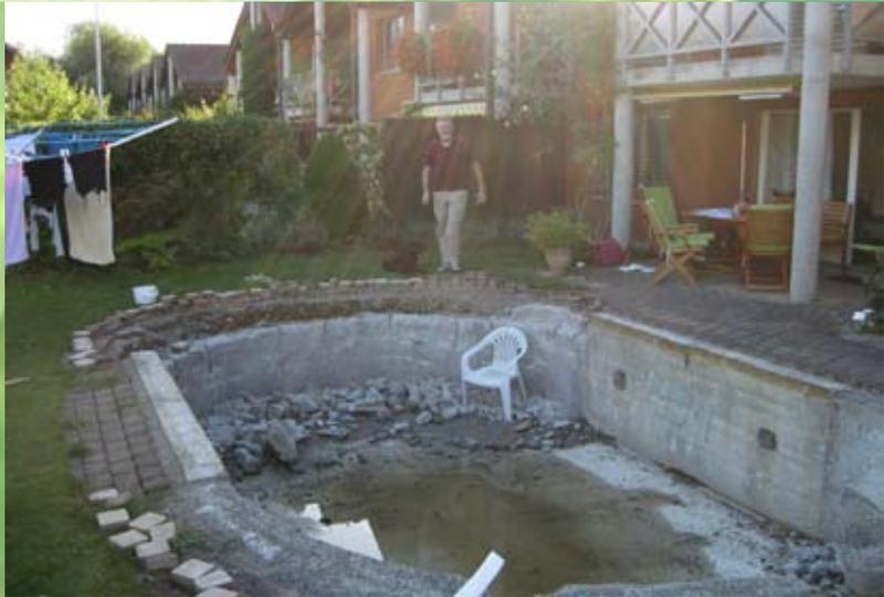
Je nach Zustand des Pools wird dieser vorher mit einer Folie neu abgedichtet. Es entfallen aber die gesamten Aushubkosten.
