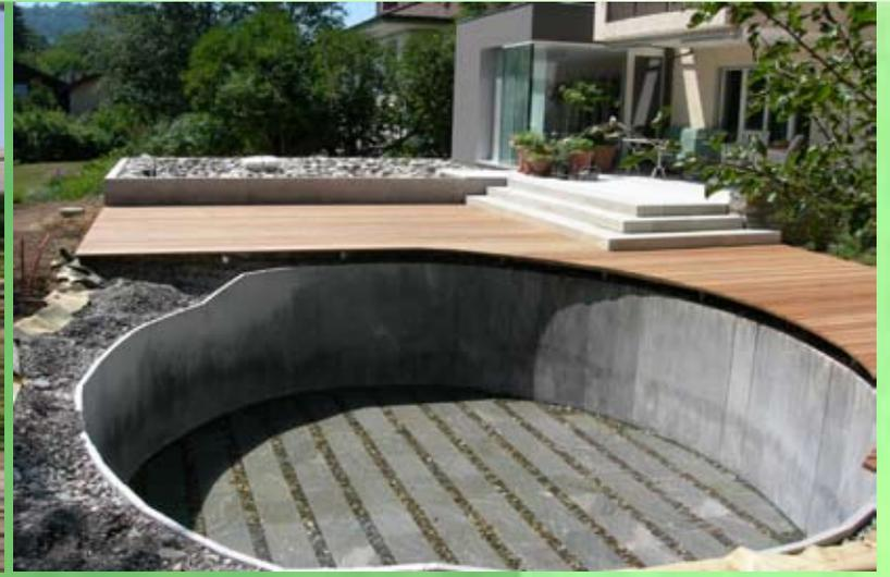
auf die von uns gewünschten Masse geschnitten und mit der vorgegebenen Oberflächenbehandlung (gesägt oder geflammt) versehen. Die gestellten Platten sind 4 cm stark und in einem speziell vergüteten und abdichteten Betonfundament eingespannt. Der Weiher wurde vor mehr als einem Jahr in Betrieb genommen und ausser ein paar Blättern haben sich am Boden oder den Wänden des Badebereiches absolut kein Mulm und keine Algen angesiedelt. Selbst im
